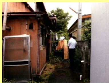
老朽危険空き家解体準備
