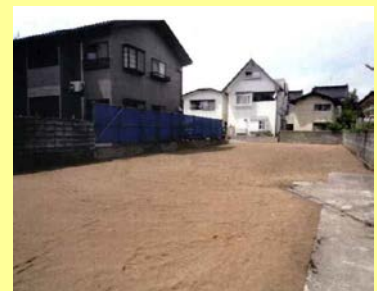
老朽危険空き家解体後
